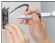
Отрегулируйте положение монтажного основания и затяните винт.
